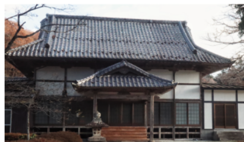
大義山 覚照寺（宮城県黒川郡大和町）
